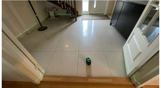
Måling av retningsavvik
