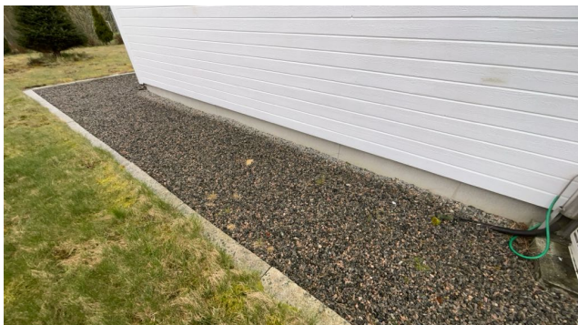
Ringmur av betong
