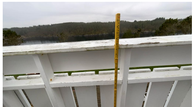
Rekkverkshøyde 90 cm.
