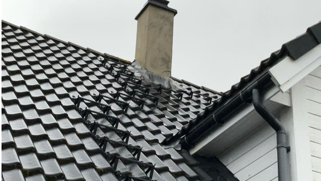
Utvendig pipe over tak og stigeledd.
