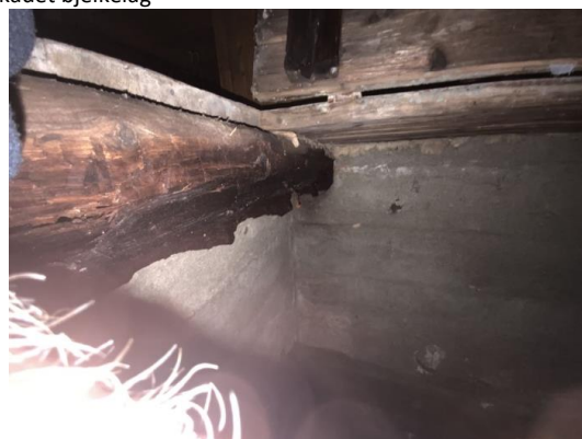
Råteskadet bjelkelag
