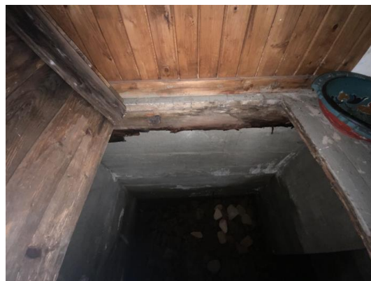
Råteskadet bjelkelag
