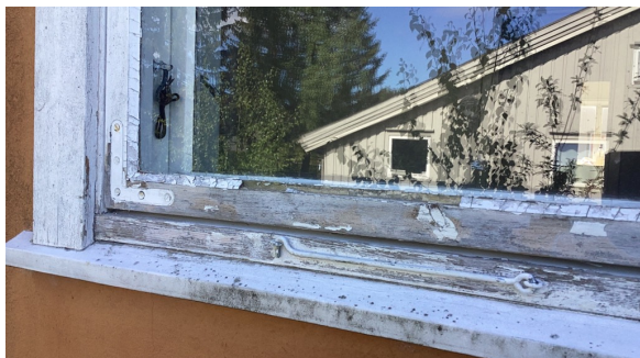
Eksempel på tilstand. Kitt begynner å skale av.
