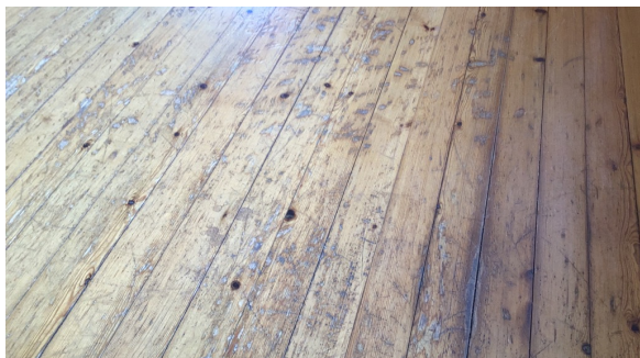
Eksempel på slitasje på overflater på gulv.
