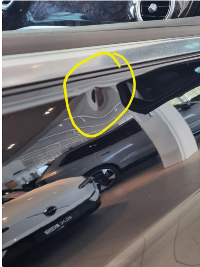
1.1 Liten bulk rett under vindu (blir forsøkt utbedret)
