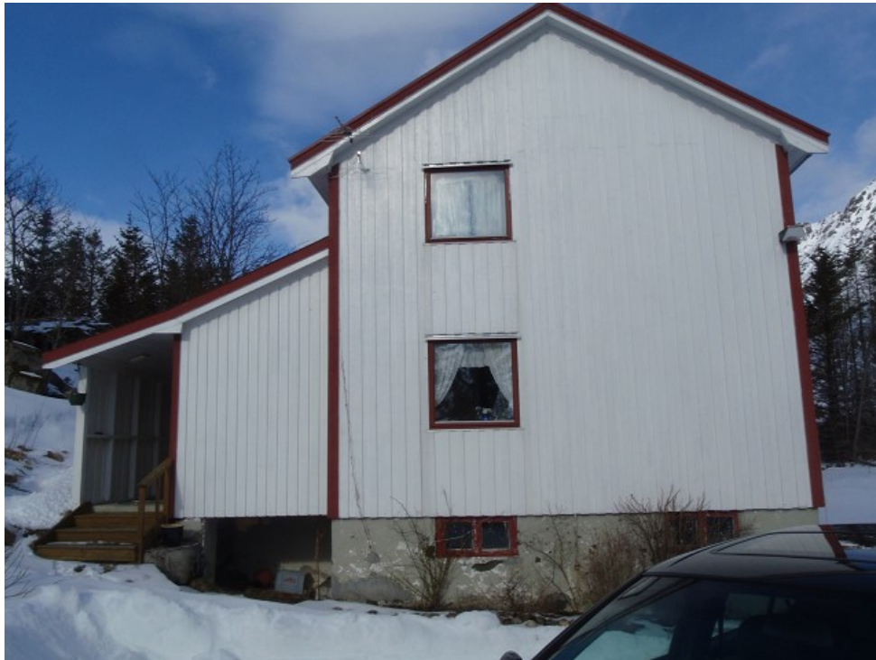
Bolig fasade syd
